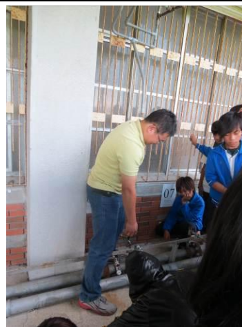
水電工 part 2，學會換裝水龍頭，家中漏水也能自己修
